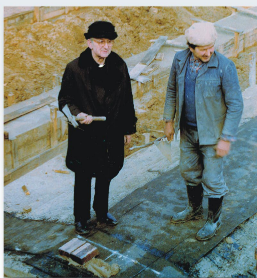
Ks. Aleksander Woźny na placu budowy nowego kościoła parafialnego
